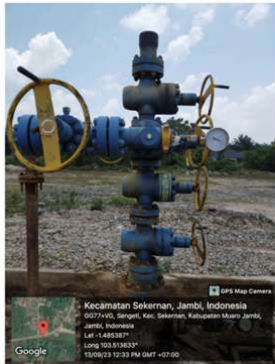
Gambar 4.4 Pompa Sumur Tua Yang Sudah Di Perbahurui
