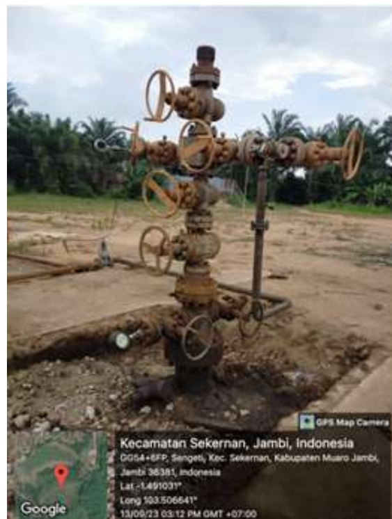
Gambar 4.2 Pompa Sumur Tua Belanda
